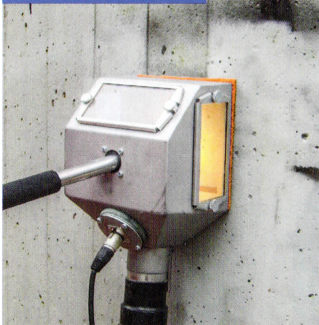
Reinigen von Waschbeton
